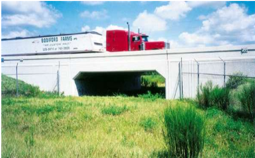
Imagen 5. Pasos de fauna como alcantarilla
